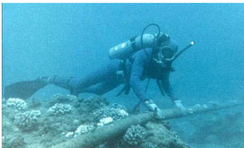
Slika 8 Primjer polaganja (sidrenja) kabela telekomunikacijske infrastrukture na dno mora
