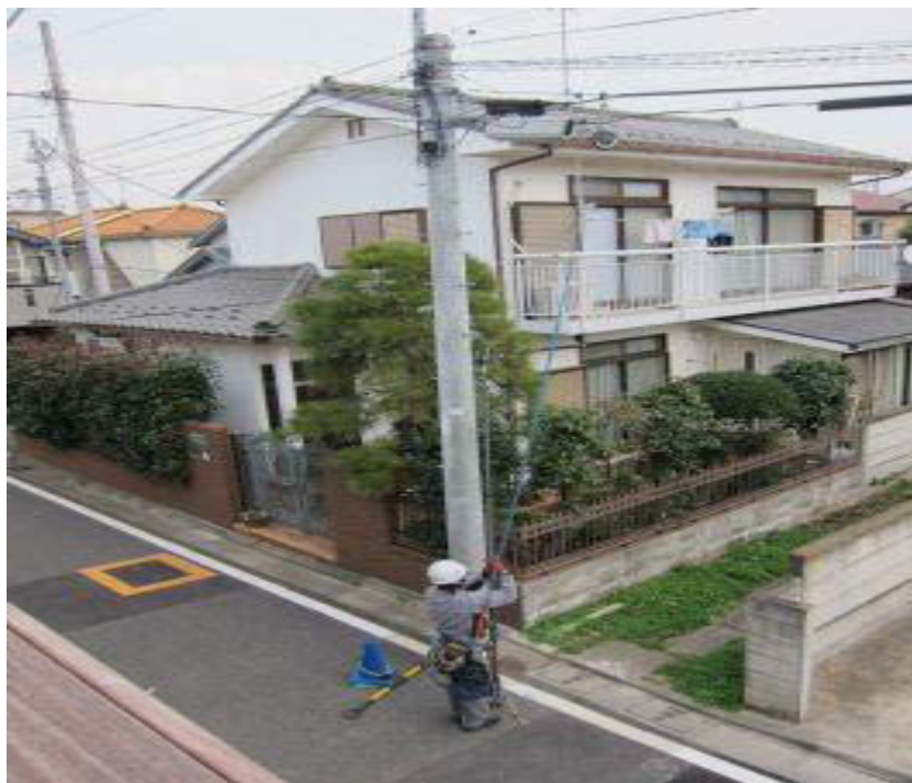
Slika 9 Primjer postavljanja svjetlovodnih kabela putem nadzemne mreže
