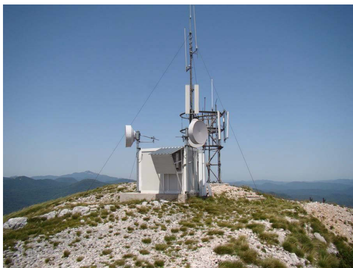
Slika 10 Primjer br. 1 uspostave bežične veze točka-točka koja podrazumijeva postavljanje antena na postojeći ili novi stup
