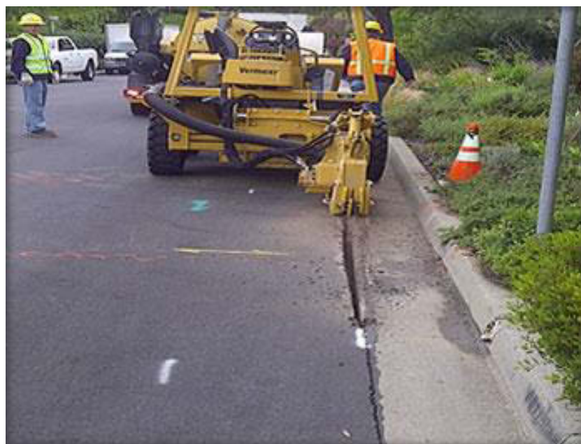
Slika 6 Primjer br. 2 kopnenih građevinskih radova
