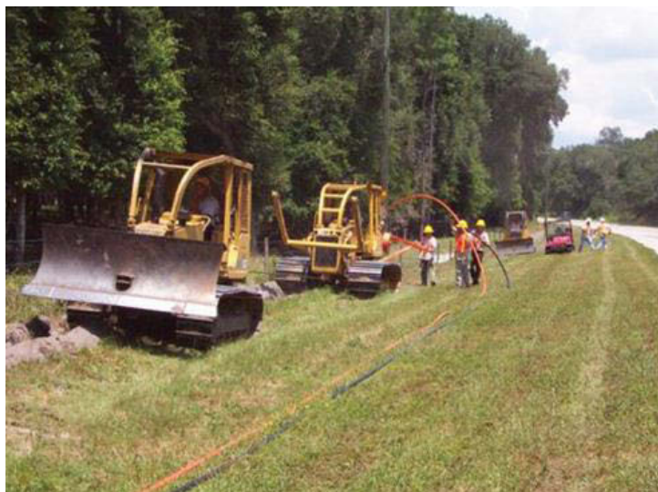
Slika 5 Primjer br. 1 kopnenih građevinskih radova
